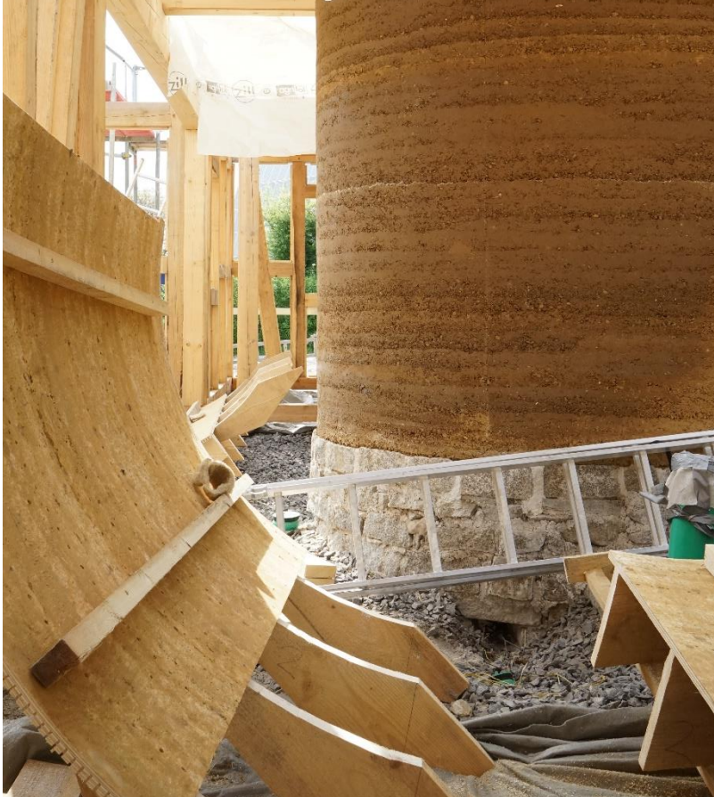
Abbildung 2: Gebogene Stampflehmwand im Neubau
