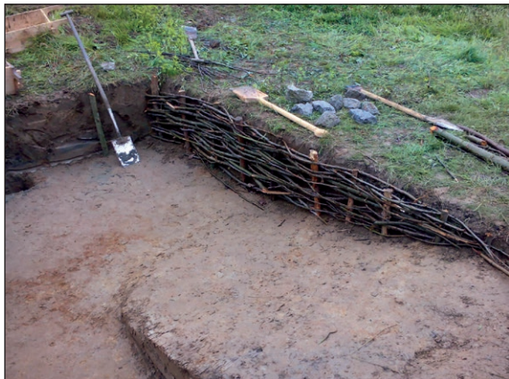
■ Obr. 5 První dokončený výplet zahloubené stěny polozemnice.
