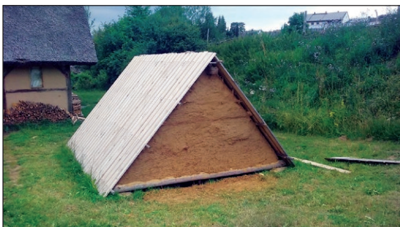
■ Obr. 11 Polozemnice s provizorním krytím fošnami a dokončenou úpravou vnějších stěn.
