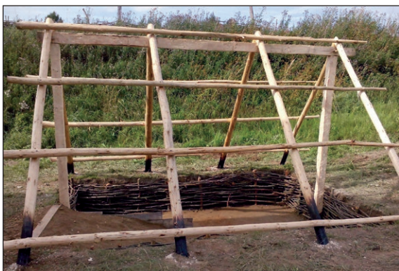
■ Obr. 10 Usazení osmi krokvic a osmi střešních prvků z tyčoviny.
