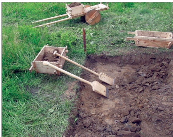
■ Obr. 3 Dřevěné nářadí použité při výkopu základů polozemnice.
