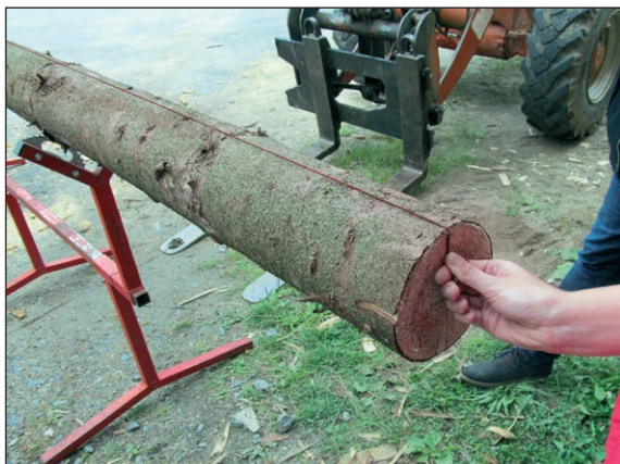
■ Obr. 6 Vyměřování profilu budoucího nosného trámu.
