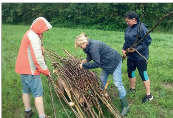
■ Obr. 4 Příprava materiálu na výplet stěn.
