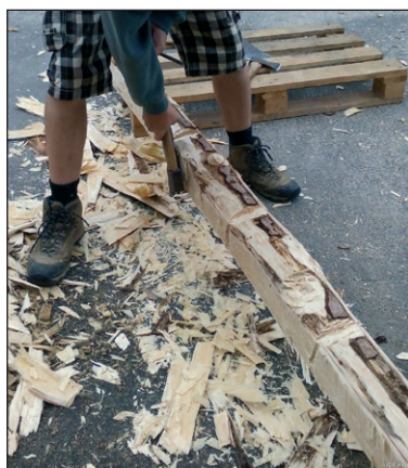
■ Obr. 7 Technika odstranění kůry a tesání trámu mezi záseky.
