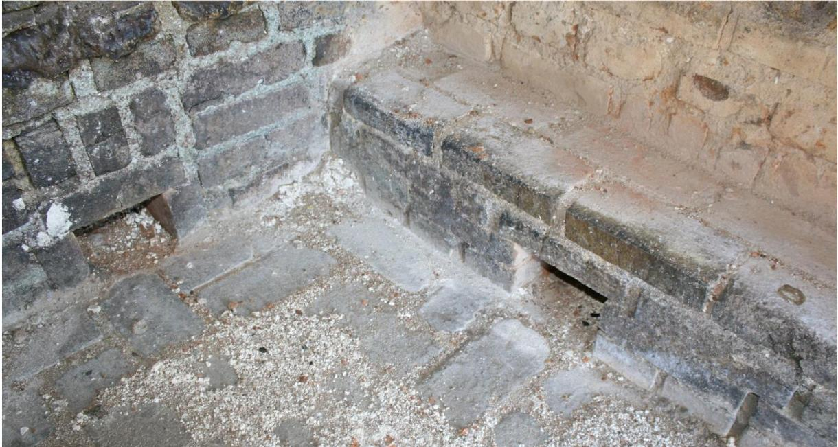
6. Die Fugen, die aus einem Kalk-Lehm-Mörtel bestehen, sind nahezu feuerfest. Dazu wird der 3:1 Mischung (3 Sand, 1 Kalk) so viel Lehm beigemischt, dass der Mörtel in der Verarbeitung eine klebrige Konsistenz erreicht.
