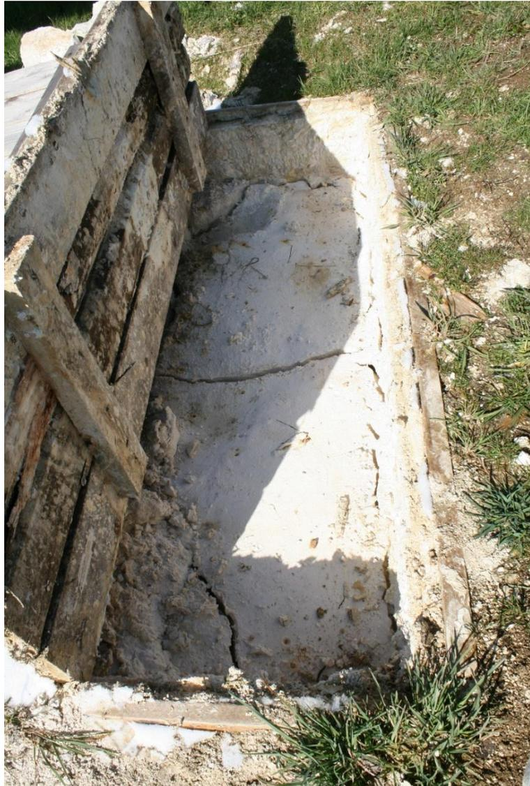
36. Um den Kalk in der Grube unbegrenzt lagerfähig zu halten, ist dafür zu sorgen, dass seine Oberfläche vollständig mit Wasser bedeckt ist.
