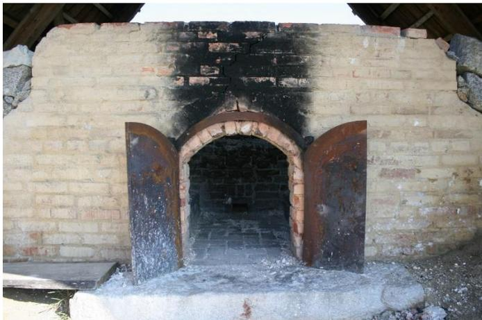
2. An der Schüröffnung ist ein Metalltor angebracht, um die Luftzufuhr reduzieren zu können und die Hitze im Ofen zu halten. Das Metall leidet stark unter den hohen Temperaturen und muss nach einigen Brennvorgängen ausgetauscht werden.
