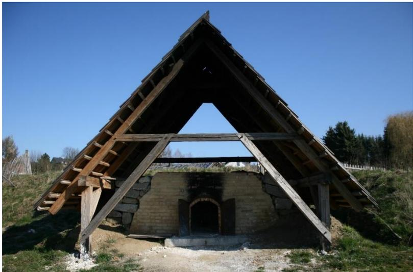
2,5 Tonnen Kalkstein entspricht. Das Grundmaterial sind Ziegelsteine und ein nahezu feuerfester Kalkmörtel und wegen der besseren Temperaturhaltung ist er auf drei Seiten mit Erde angeschüttet. Am Boden des Brennraumes sorgen drei Luftzüge für eine saubere Verbrennung und hohe Temperaturen. Aufgrund der großen Arbeitstemperaturen ist der Ofen mit einem Dach gegen Witterungseinflüsse geschützt.
