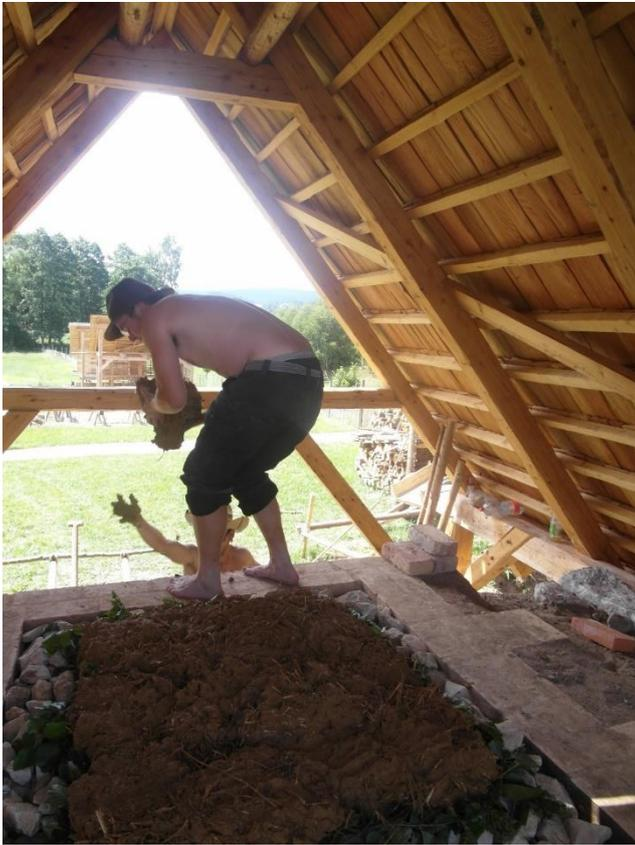
18. Zwischen Ofenwand und Lehmdeckelrand bleiben circa 10 cm unbedeckt, um ausreichenden Luftzug für den Brandvorgang zu gewährleisten. Während des Brennens kann der Zug der Flamme durch Abdecken des Randstreifens mit Ziegelsteinen gesteuert werden,
