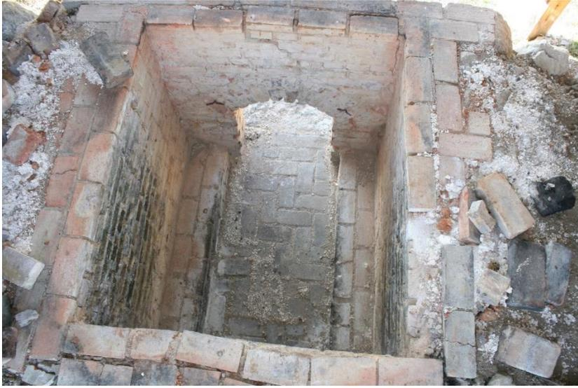
3. Der nach oben offene Brennraum hat an beiden Seiten der Brennfläche einen Ziegelsockel, dieser unterstützt das Aufsetzen eines Trockengewölbes aus dem zu brennenden Sandstein, unter dem schließlich das Feuer angelegt wird.
