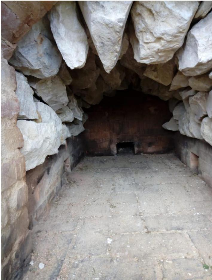
14. Trägt das Gewölbe und ist der Ofenraum befüllt, werden Vorbereitungen für den oberen Abschluß der Brennkammer getroffen. Hierzu wird zunächst eine Schicht aus belaubten Zweigen als Trennschicht auf die Sandsteine aufgebracht, damit sich der folgende Lehmdeckel beim Brennvorgang nicht mit den Sandsteinen verbindet.
