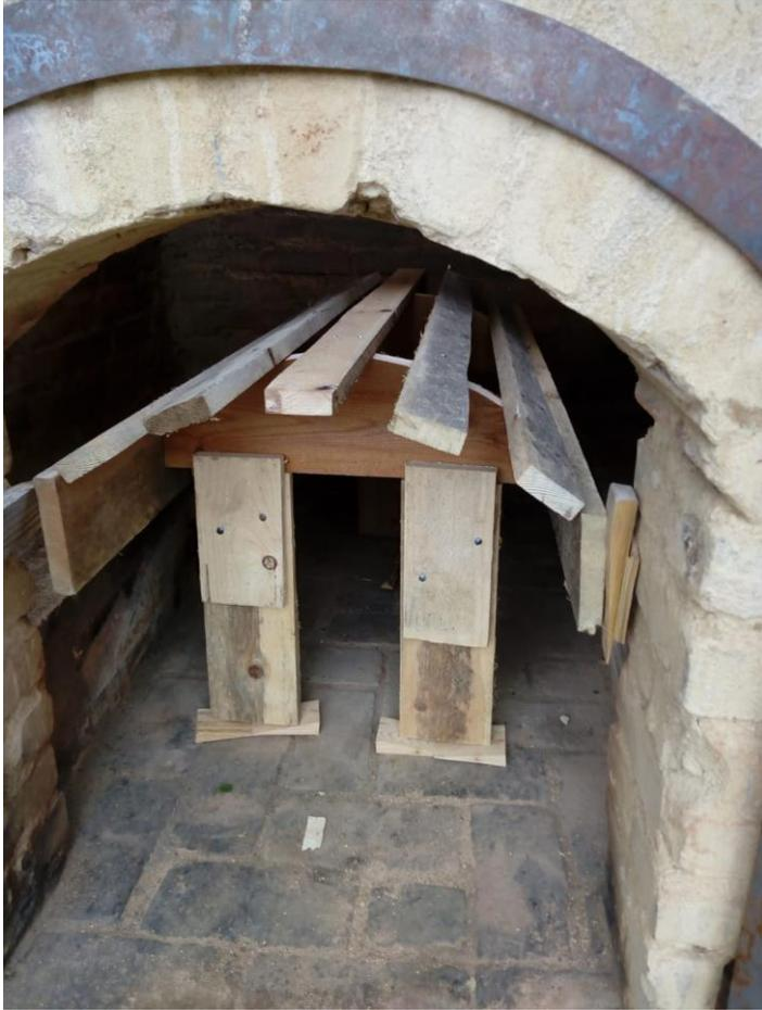
9. Um ein Trockengewölbe, in diesem Fall ein einfaches Tonnengewölbe, aufsetzen zu können, wird eine Holzschalung benötigt. Beim Aufsetzen wird diese Konstruktionshilfe mit Keilen ca. drei Zentimeter in die Höhe gedrückt. Nach Entfernung der Keile kann so die Holzkonstruktion durch die Schüröffnung entnommen werden und das Gewölbe ist freistehend.
